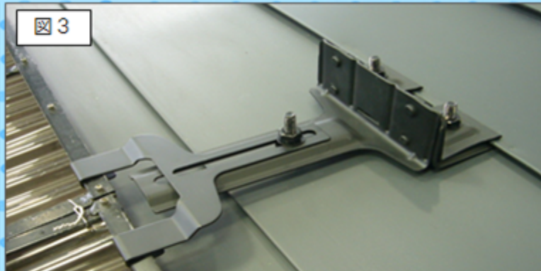
ダブル取付金具使用例と本体同士連結時の結束例
